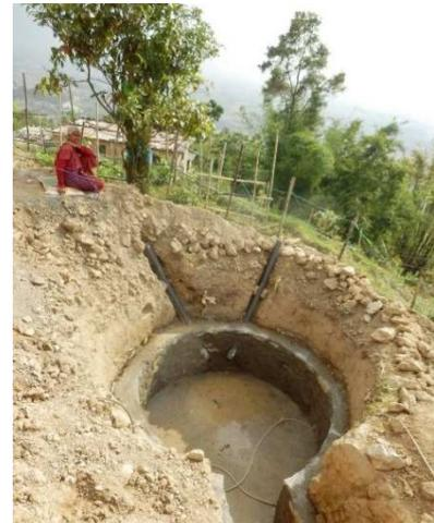
Aufbau einer Biogasanlage |
